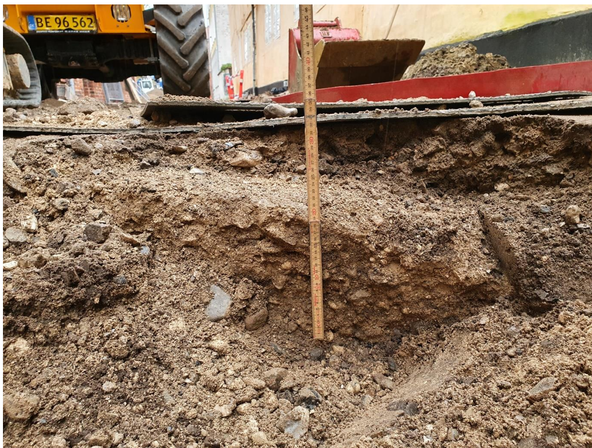
Figur 7. Smal rende af rent stabilt grus som bærelag over tidligere udført ledningsgrav.
