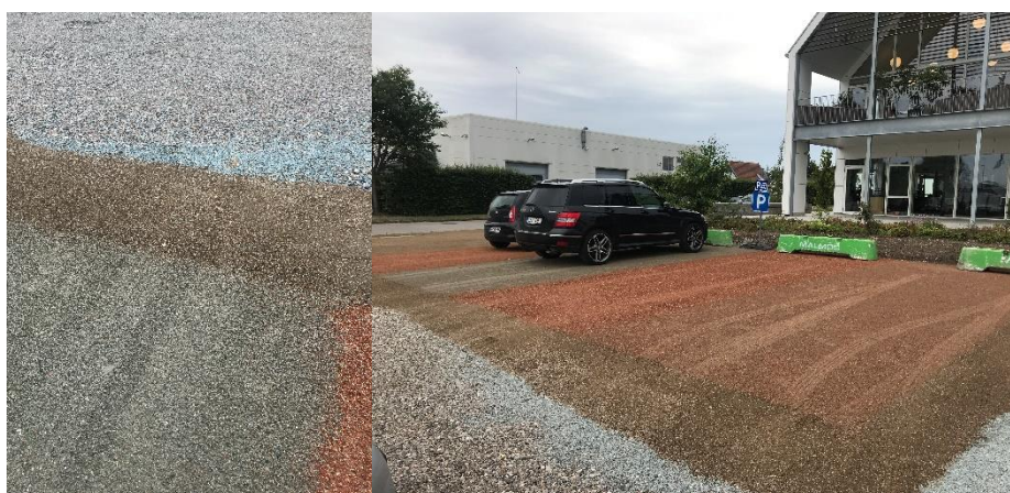
Figur 14. Kørespor i det udlagte materiale.
