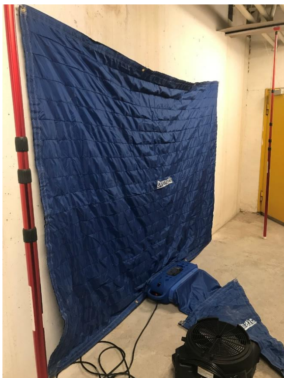
Figur 3. Testopstilling ved betonvæg
