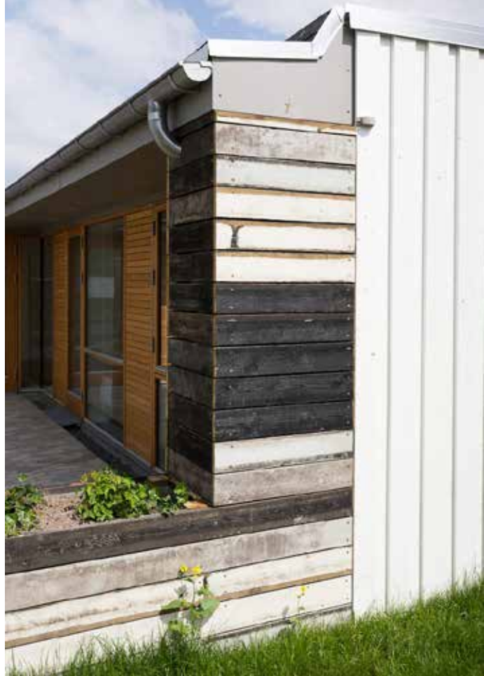
Mock up af facadebeklædning af genbrugstræ
