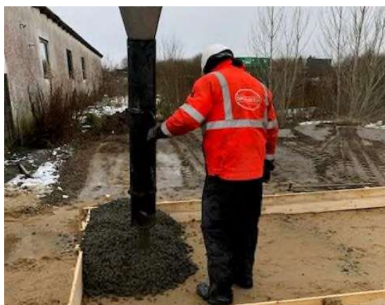
Figur 2 - Støbning af prøvelfelter med recept P32 og E16.
