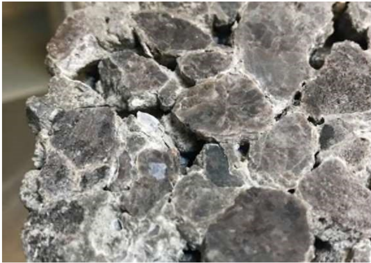
Figur 10 - Revnedannelse i bunden af en E25 cylinder efter endt frost/tø test.
