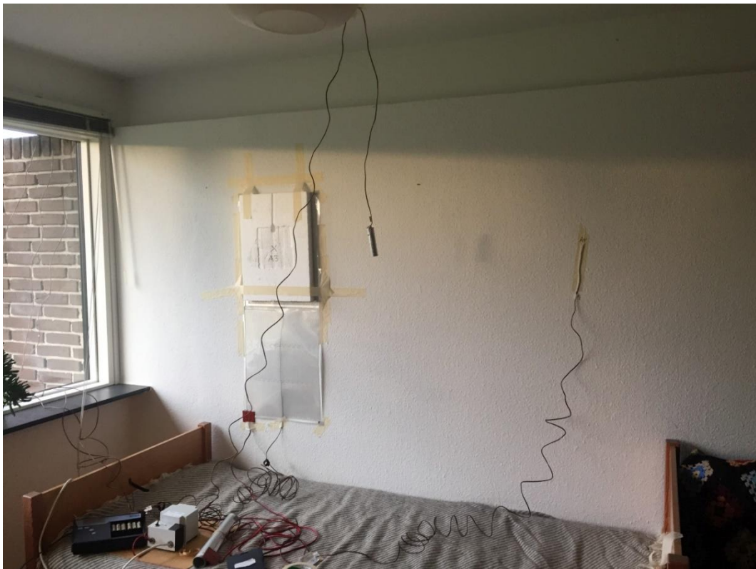
Figur 50: Testet væg set fra kontor
