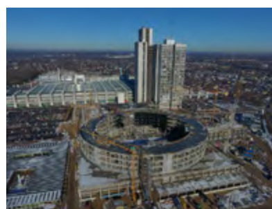
Herlev Hospital Opmåling, afsætning og projektgrundlag
