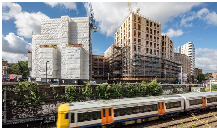
Figur 2: Dalston Lane under opførelse.
