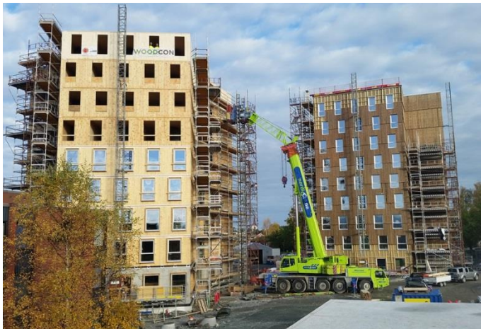
Figur 3: Studenterboliger i Trondheim under opførelse.
