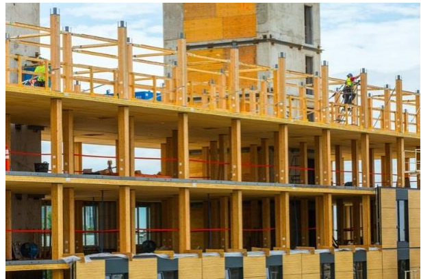
Figur 5: Hybridkonstruktion med limtræssøjler og CLT-bjælker. Kilde: Acron Ostry Architects, Foto: KK Law.
