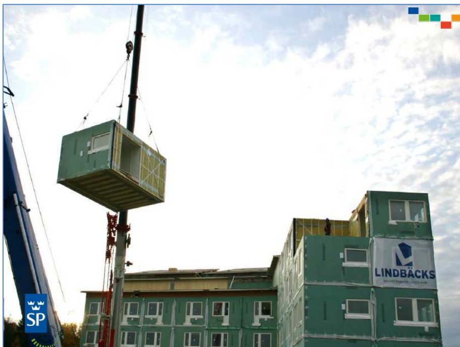
Figur 4: Eksempel på byggesystem med rumstore moduler. Præsentation fra temadagen "Gentænk træ som bærende bygningsdele i høje bygninger", Pierre Landel, SP Wood Building Technology
