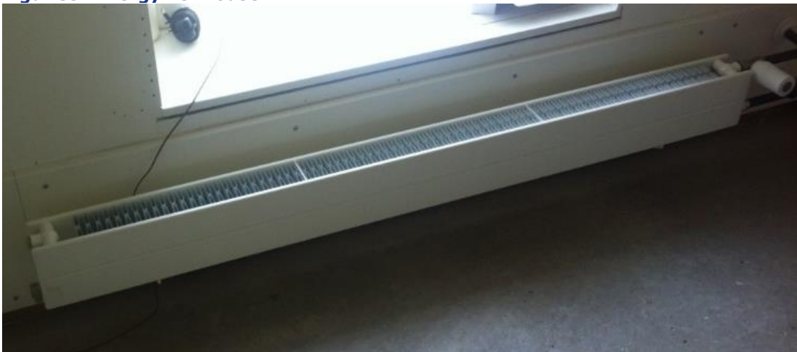
Figur 40: Konvektor ved vindue i EnergyFlexHouse
